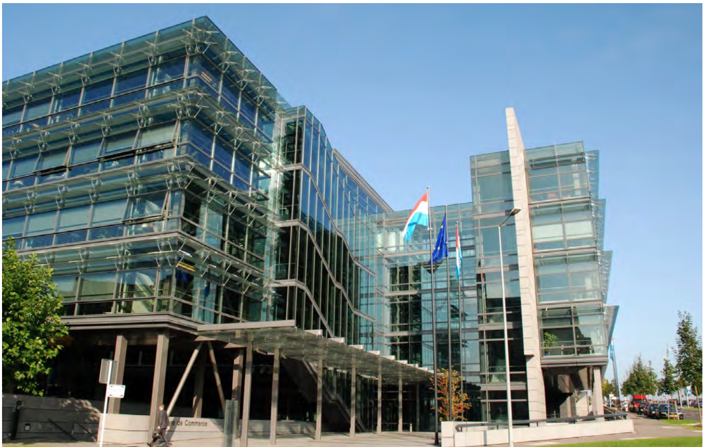
Figuur 1-5 : Met het natuurlijkebrandconcept is soms aan te tonen dat een staalconstructie onbeschermd kan blijven (Chambre de Commerce te Kirchberg, Luxemburg, LU).
